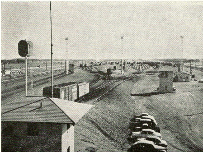
Sporanlægget på godsbanegården i North Platte, Nebraska. Fra kontrollårnet dirigerer den »tænkende« automatiske »rangermester« godsvognene ind på de forskellige spor og sammenkobler dem under hensyn til deres bestemmelsessted.
